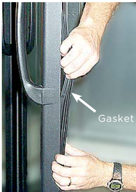
Remove Door Gasket
