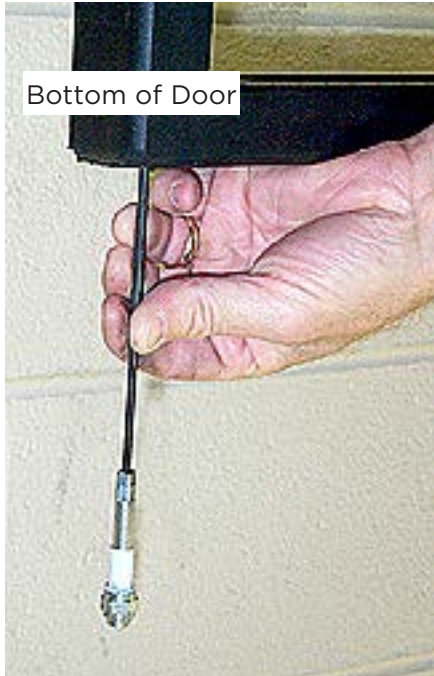
Replace Door Hinge Spring
